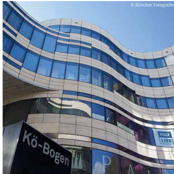
Der Düsseldorfer Kö-Bogen mit REGUPOL Trittschalldämmung aus Recyclingmaterial.
