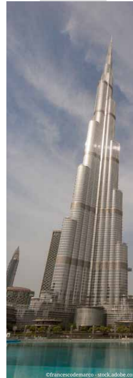
Die Trittschalldämmung im Burj Khalifa/Dubai kommt von REGUPOL aus Deutschland.
