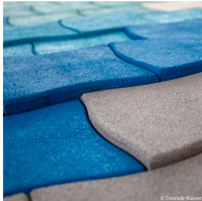
Recyclingmaterialien mit farbiger EPDM-Oberfläche ermöglichen eine kreative Flächengestaltung.
