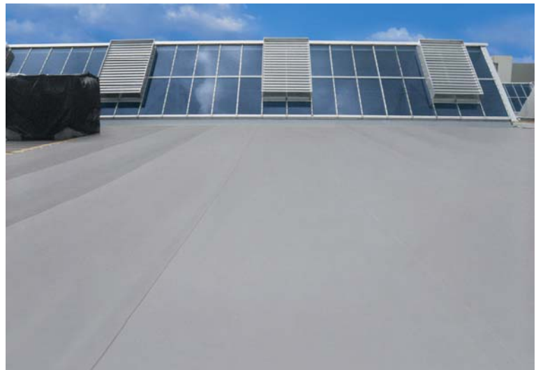
Rationelle Dachabdichtungen mit hellgrauen EPDM-Bahnen
