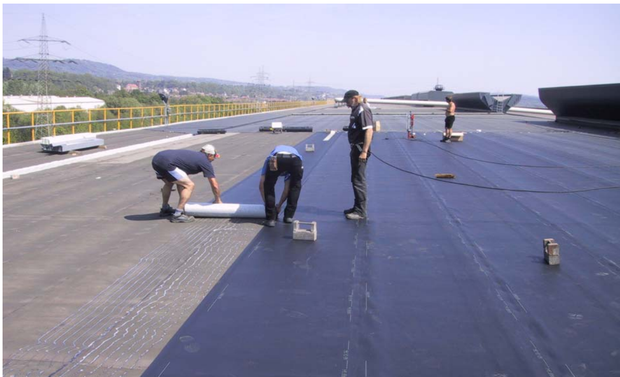
Teilflächige Verklebung einer Kautschukbahn
