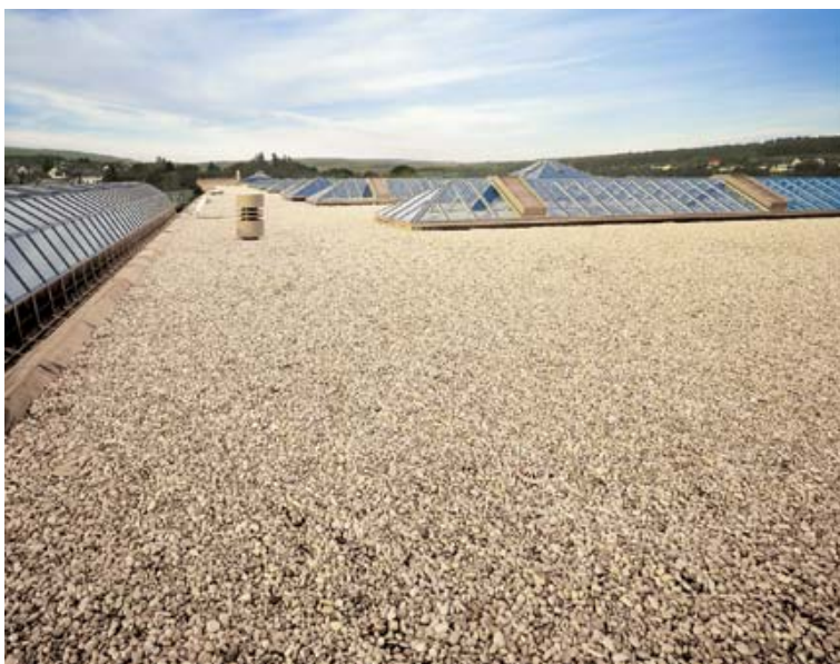
Kiesdach auf EPDM-Planenabdichtung
