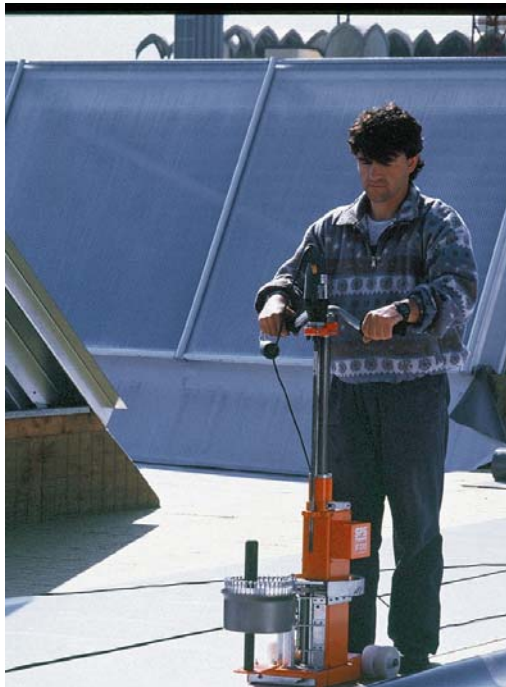
Mechanische Befestigung einer Kautschukbahn
