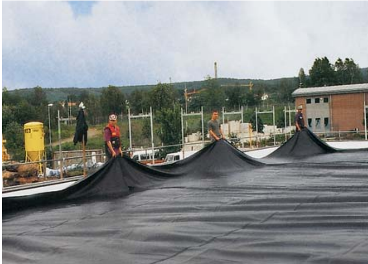
Ausbreiten und Verlegen einer Kautschukplane
