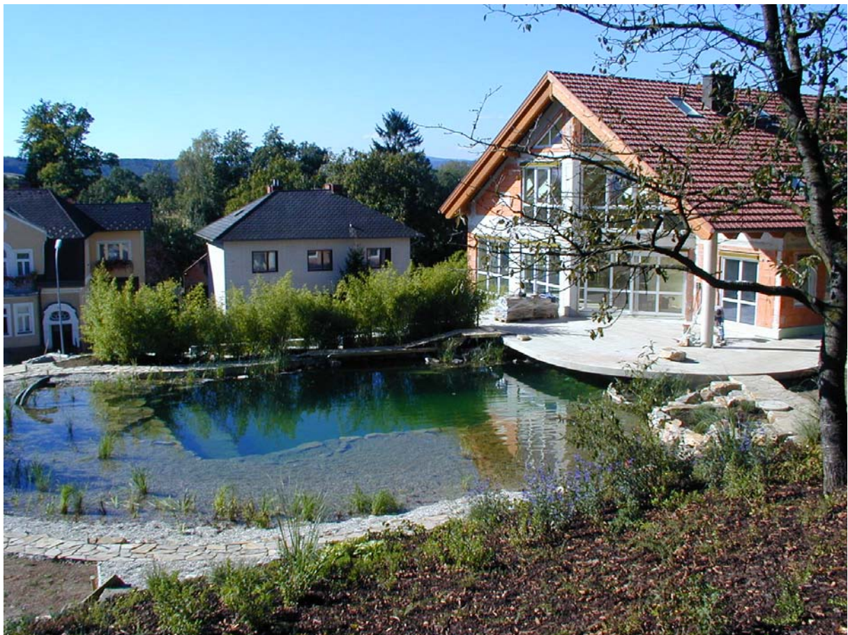
EPDM-Abdichtung für einen Schwimmteich Foto: Duraproof
